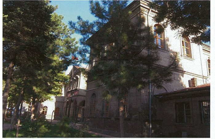
Fotoğraf 5: Kayseri Lisesi giriş cephesinin görünüşü
